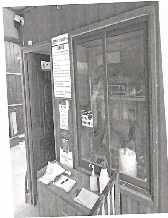
工地入口处设置摄像头，实时监督工人扫嘉行码后进入施工现场
