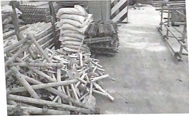
现场原材料要做好必要的防护避免二次除锈
